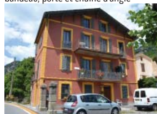
Modénature encadrements de fenêtre, bandeau, porte et chaine d'angle
