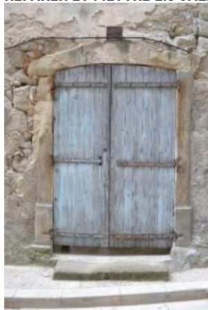
Réparation ou changement des pierres d'encadrement à prévoir et reprise d'enduit pour protection du mur
