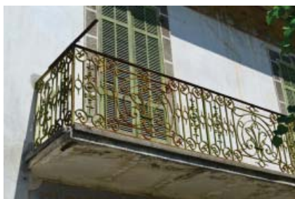
GARDE CORPS OUVRAGÉ SUR BALCON A CONSOLE EN FER
