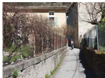
CLÔTURE CHEMIN VERS LA VILLE
