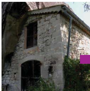
MAISON CONTRE ROCHE
