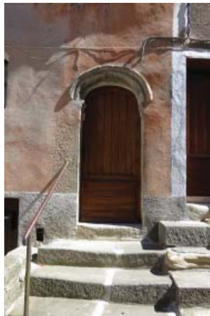
Mise en valeur des piliers d'encadrement pierre possible avec enduit à pierre vue
