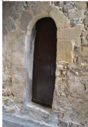
Réparation ou changement de pierres d'encadrement à prévoir et reprise d'enduit pour protection du mur
