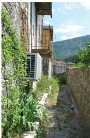
SITUATION QUI PEUT FAVORISER L'INCONFORT SUR LES VOIES, RUES ET CHEMINS
